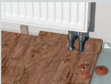
**4** Bei Heizungsrohrdurchbrüchen die Diele am Stoß ausklinken und mit Heizkörperrossetten abdecken.
