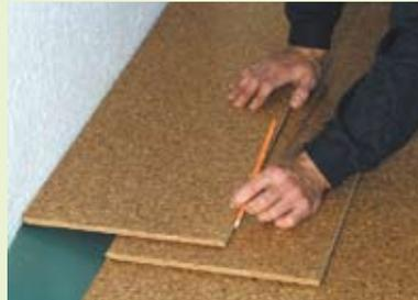
**6** Einpassen der letzten Dielenreihe: Legen Sie exakt auf die zuletzt verlegte Dielenreihe die nachzusägende Diele. Dann zeichnen Sie mit Hilfe einer weiteren Dielen den Längsschnitt an.
