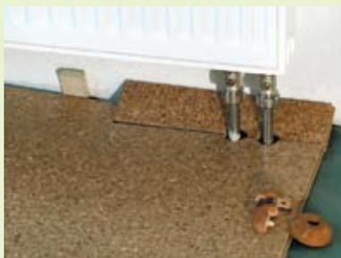
**4** Bei Heizungsrohrdurchbrüchen die Diele am Stoß ausklinken und mit Heizkörperrosetten abdecken.
