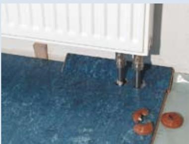
**4** Bei Heizungsrohrdurchbrüchen die Dielen am Stoß ausklinken und mit Heizkörperrossetten abdecken.
