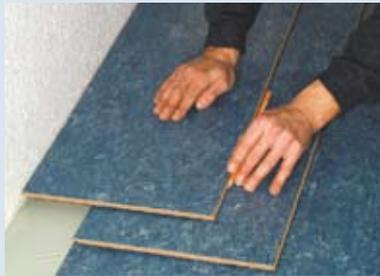
**6** Einpassen der letzten Dielenreihe: Legen Sie exakt auf die zuletzt verlegte Dielenreihe die nachzusägende Dielle. Dann zeichnen Sie mit Hilfe einer weiteren Dielle den Längsschnitt an.
